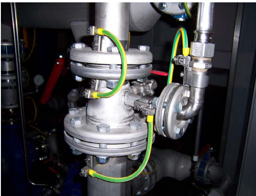
Bild 1: Überbrückungen von Leitungsflanschen mittels Erdungskabel H07VK grün/gelb 25 mm 2
