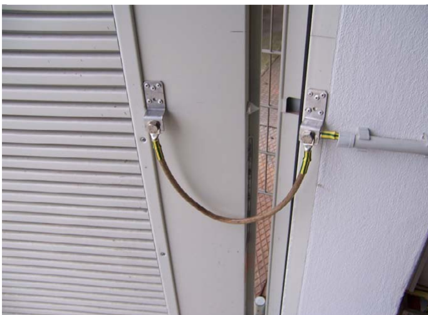
Bild 3: Flexible Überbrückung zwischen Metalltür und Türrahmen
