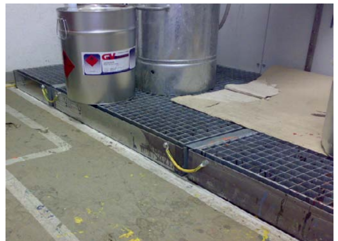
Bild 5 + 6: Spezielle Rohranschlußschellen für EX-Bereiche und Überbrückungen an Metallgestellen in einem Lacklager
