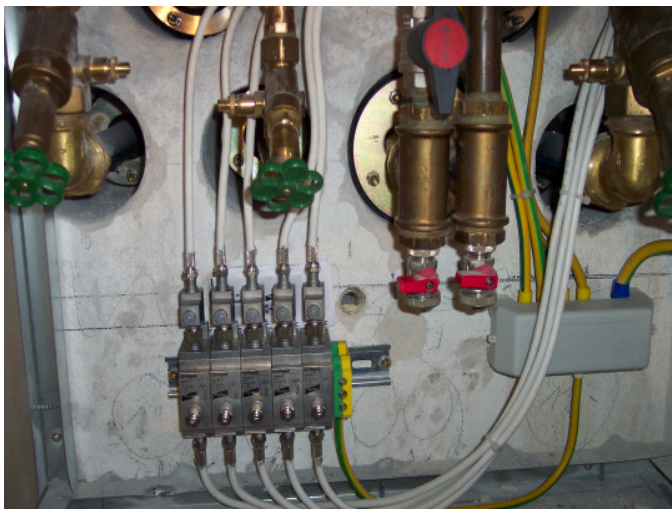
Bild 9 + 10: Überspannungsableiter für Antennenkabel (links: SAT-Antenne / rechts: Richtfunk)
