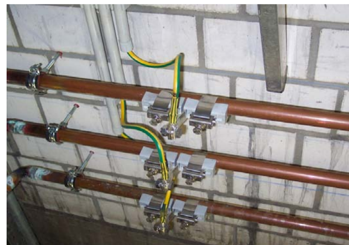
Bild 5 + 6: Spezielle Rohranschlußschellen für EX-Bereiche und Überbrückungen an Metallgestellen in einem Lacklager
